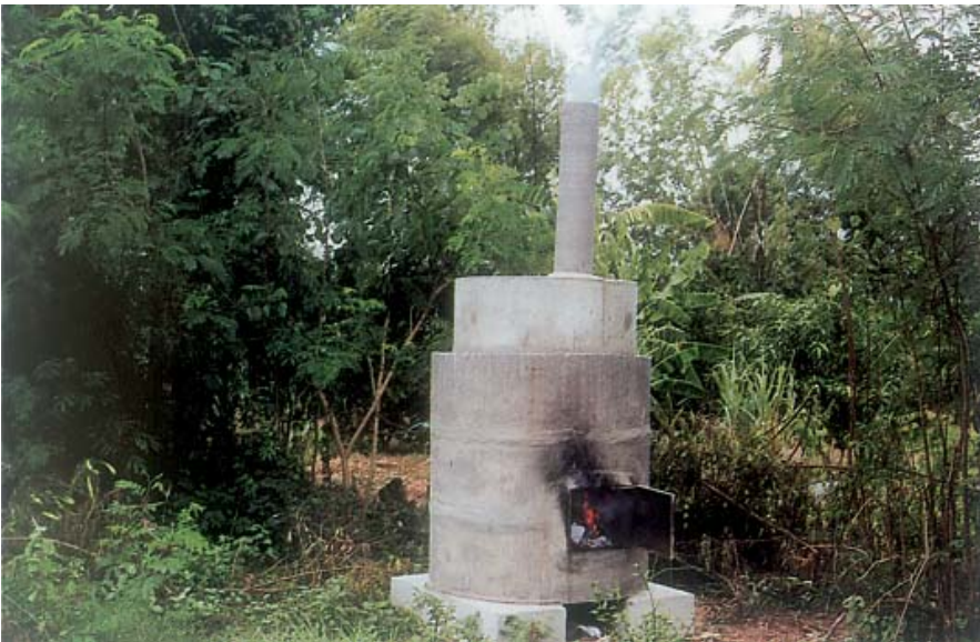
รูปที่ 9 เตาเผามูลฝอยที่ก่อสร้างในชุมชน
