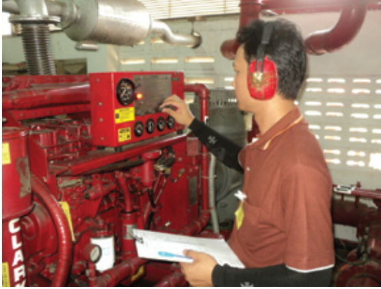
ภาพที่ ๓๗ การตรวจสอบเครื่องสูบน้ำดับเพลิง
