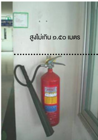
ภาพที่ ๑๗ ความสูงของการติดตั้งเครื่องดับเพลิงแบบมือถือ
