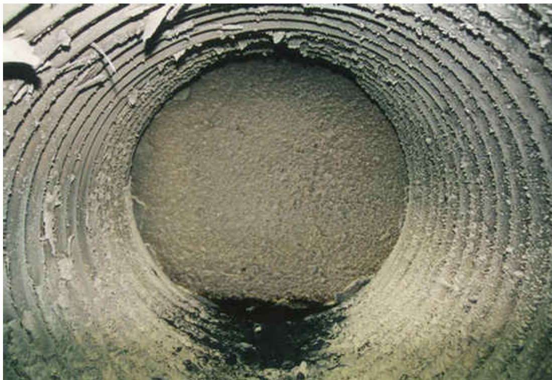
รูปที่ 3-1 เขม่าในห้องเผาไหม้
