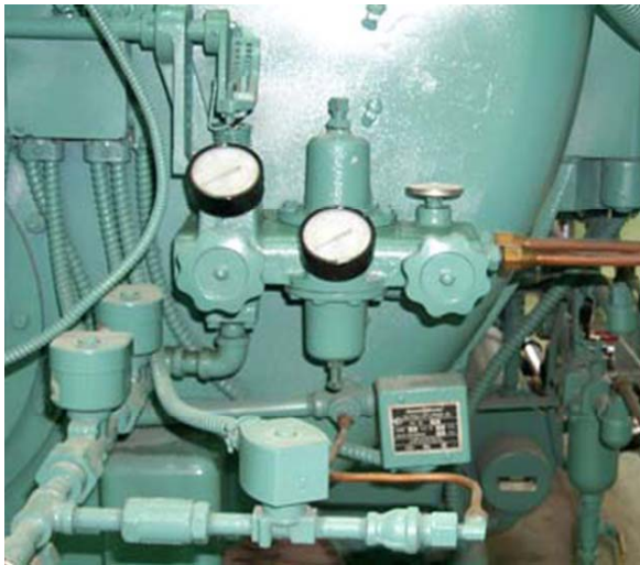
รูปที่ 6-42 ชุดควบคุมความดันของน้ำมันเชื้อเพลิง
