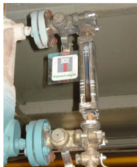
รูปที่ 4-7 หลอดแก้ววัดระดับน้ำ หรือแท่งแก้ววัดระดับน้ำ
