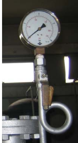
รูปที่ 4-16 การติดตั้งท่อใส่ไก่เข้ากับมาตรวัดความดัน
