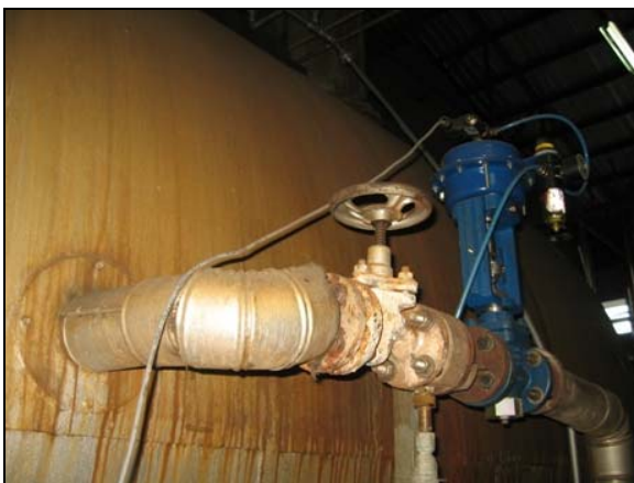
รูปที่ 4-24 การติดตั้งระบบระบายน้ำโบลด์วาร์นอัตโนมัติ
