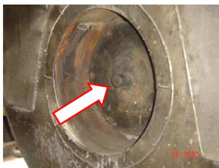
(ก) ตาไฟติดตั้งที่ท้ายหม้อน้ำ
