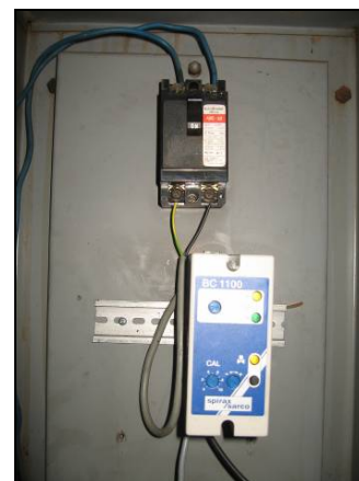
รูปที่ 4-24 การติดตั้งระบบระบายน้ำโบลด์วาร์นอัตโนมัติ
