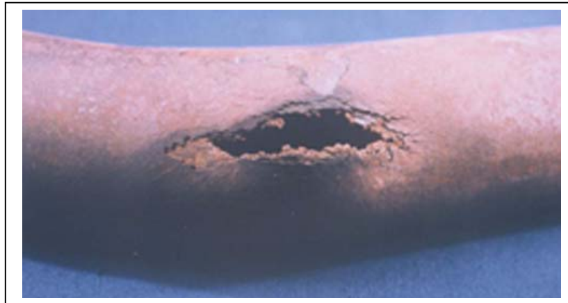
รูปที่ 6.10 แสดง Longer-term Boiler Tube Failure เนื่องจากการขาดการไหลเวียนของของไหลที่เพียงพอในท่อ และก่อให้เกิด Oxidation corrosion แล้วเกิด Stress Rupture ในที่สุด
